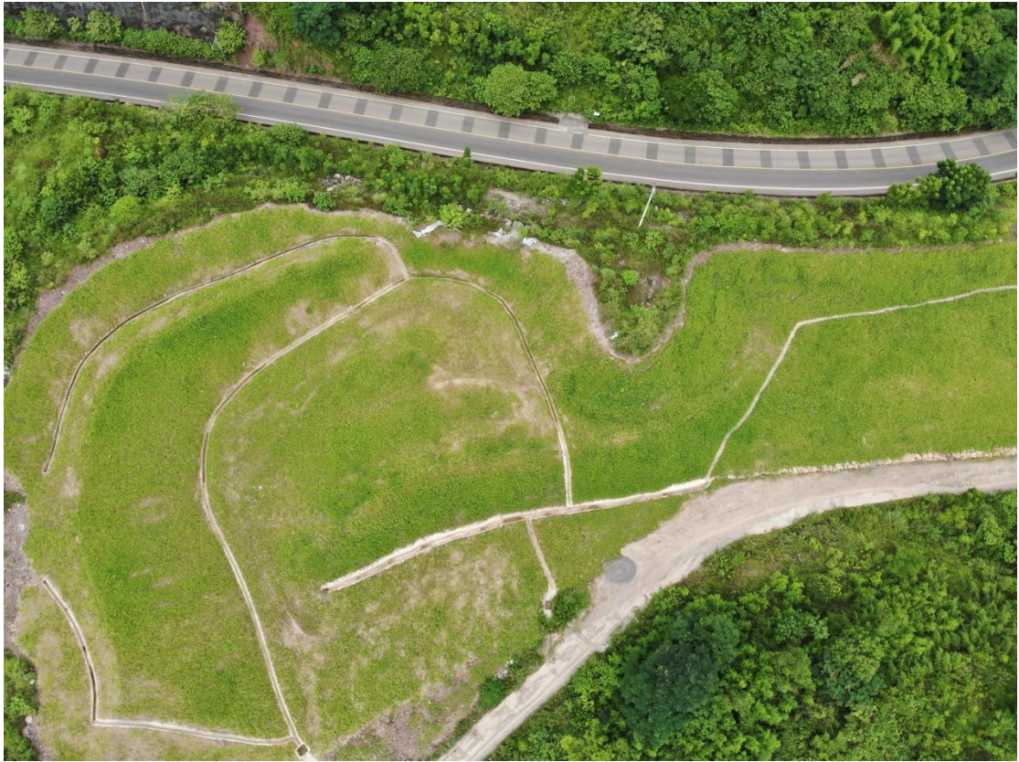
1#料场现状航拍图
