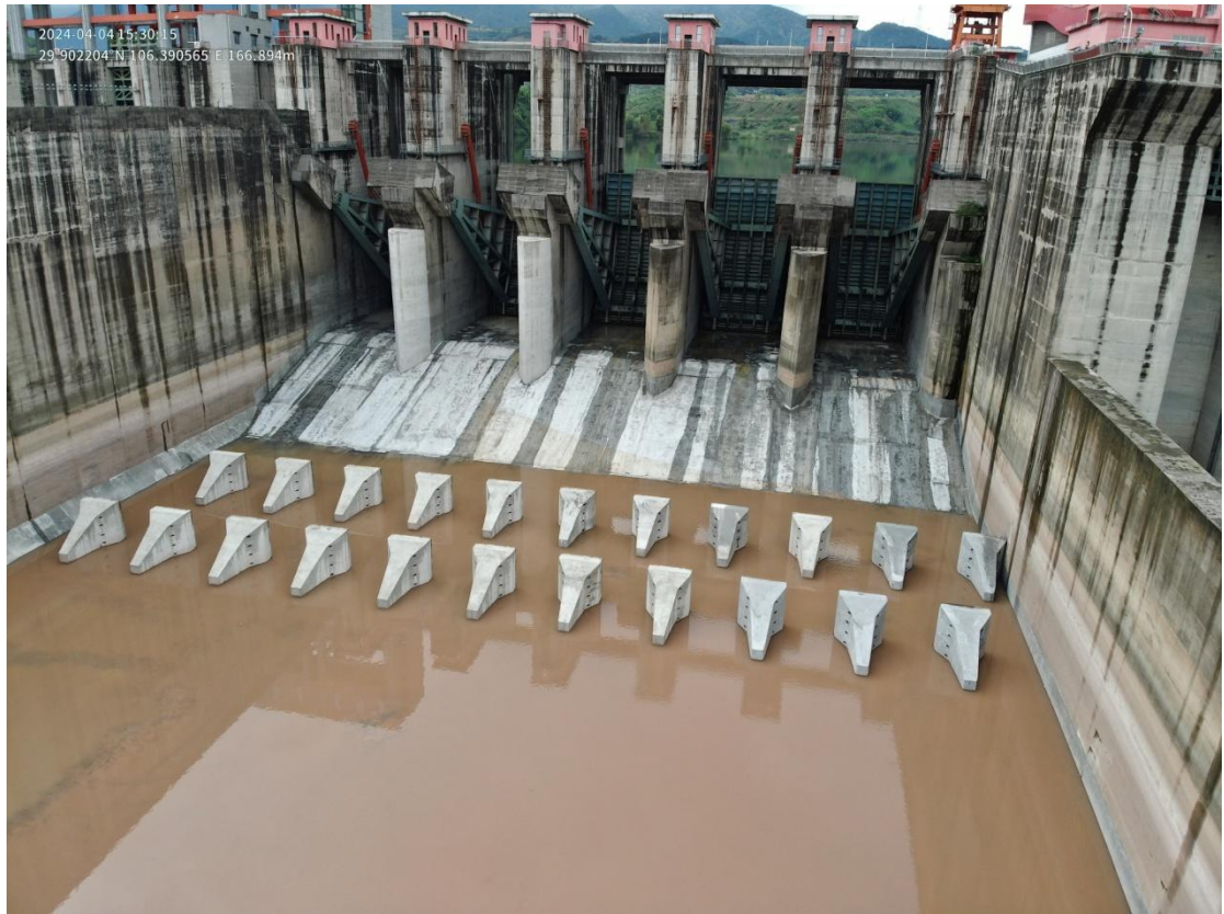
冲沙闸现状航拍图
