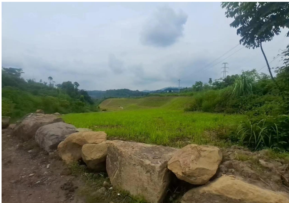
料场干砌块石拦挡现状图
