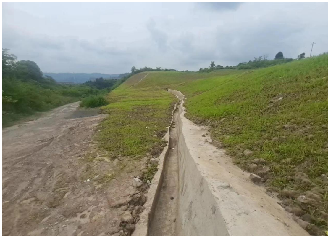
料场排水沟现状图
