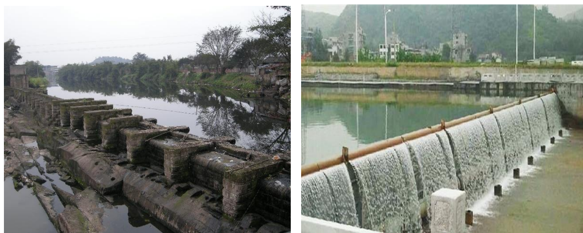
图 3-1 拆坝改闸（翻板闸）工程效果图
