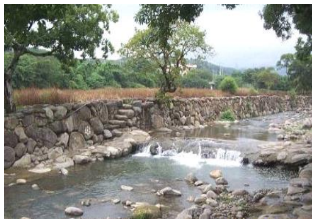
图 3-13 干砌石护岸构造效果图
