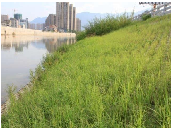
图 3-16 自锁式生态护坡砌块护岸效果图
