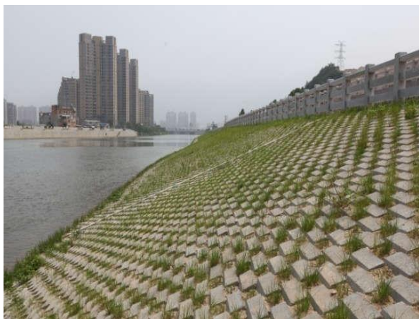
图 3-16 自锁式生态护坡砌块护岸效果图
