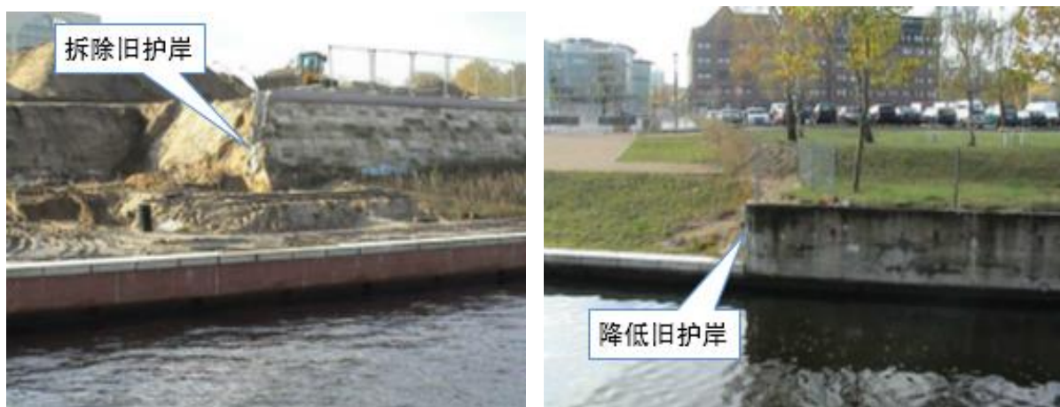
图 3-19 硬质护岸拆除改造效果图
