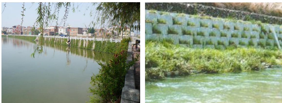
图 3-20 硬质护坡植物挂网和生态混凝土砌块改造效果图
