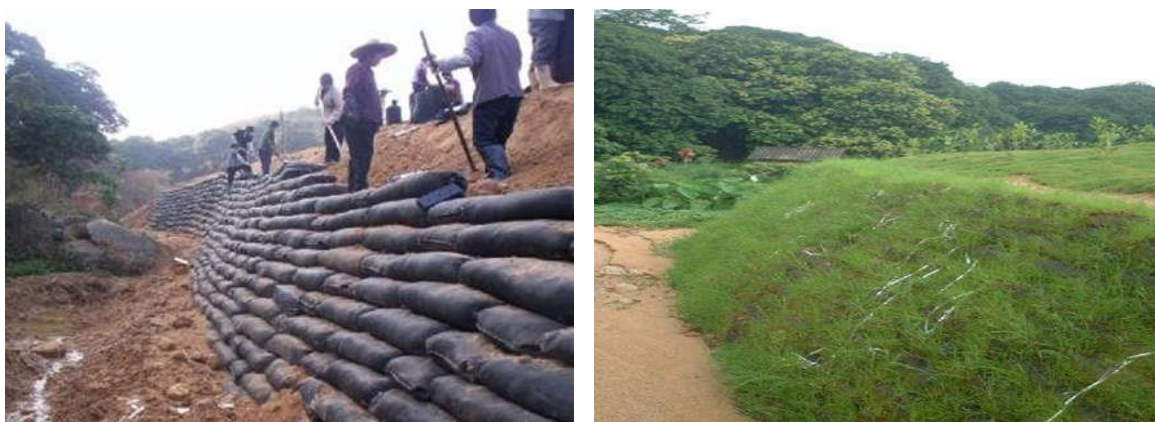
图 3-12 生态袋边坡防护效果图
