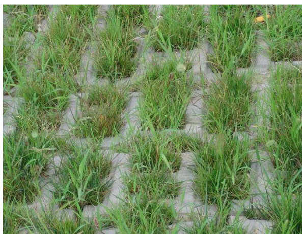
图 3-15 生态混凝土护坡效果图
