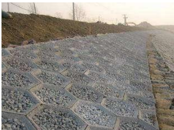
图 3-15 生态混凝土护坡效果图
