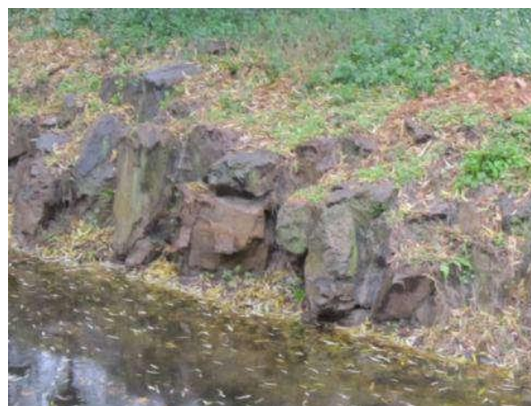
图 3-17 叠石挡墙效果图
