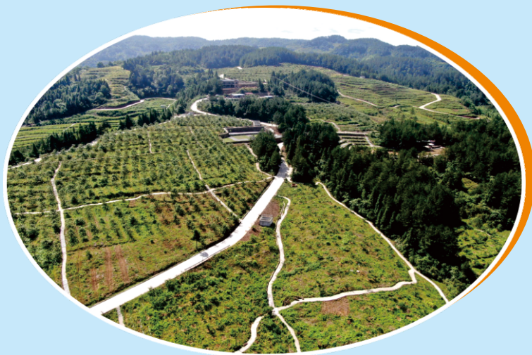
图3.6 石柱土家族自治县玉岭项目区水土保持重点工程
