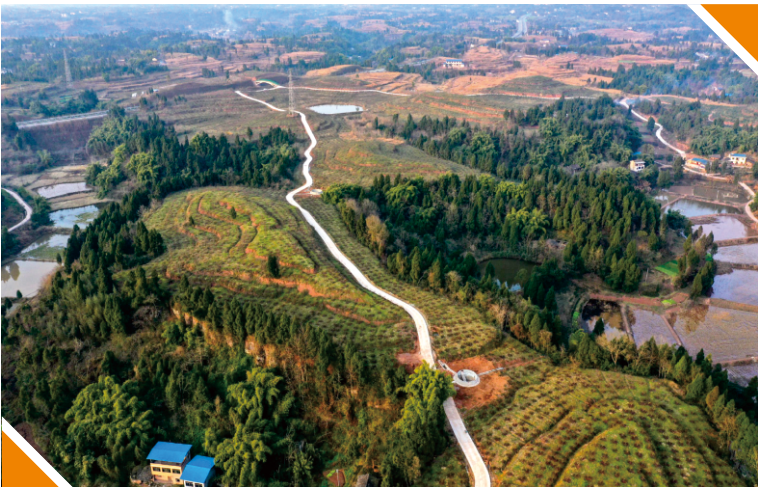
图3.3 潼南区双龙项目区坡耕地综合治理工程
