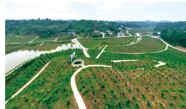
图3.2 潼南区水桥项目区坡耕地水土流失综合治理工程
