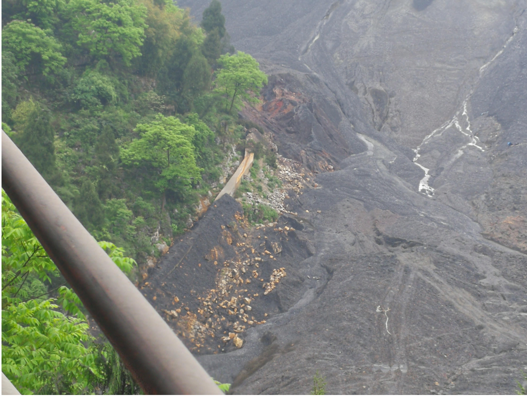
排矸场防治区；排洪沟
