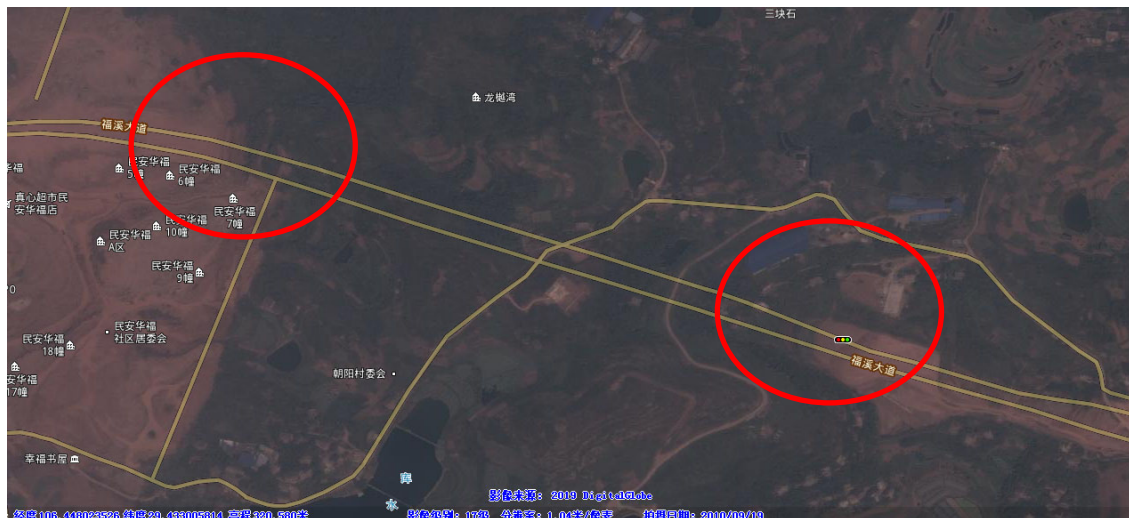
影响资料（拍摄时间 2011 年 9 月，本项目施工前洞口位置情况）
