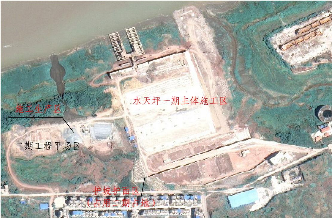
项目施工过程中扰动区域（最大扰动范围）
