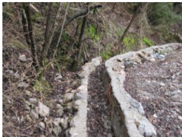
渣场排水沟（二）
