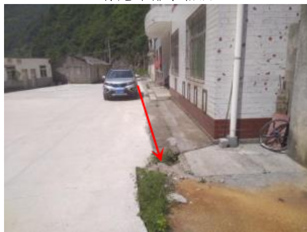
管理房排水沟
