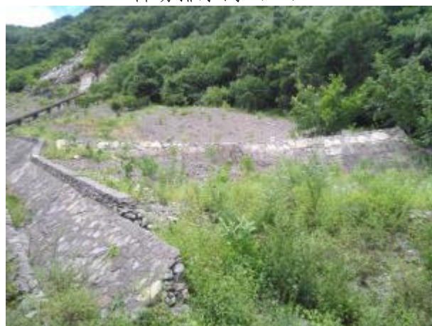
管道槽植物措施
