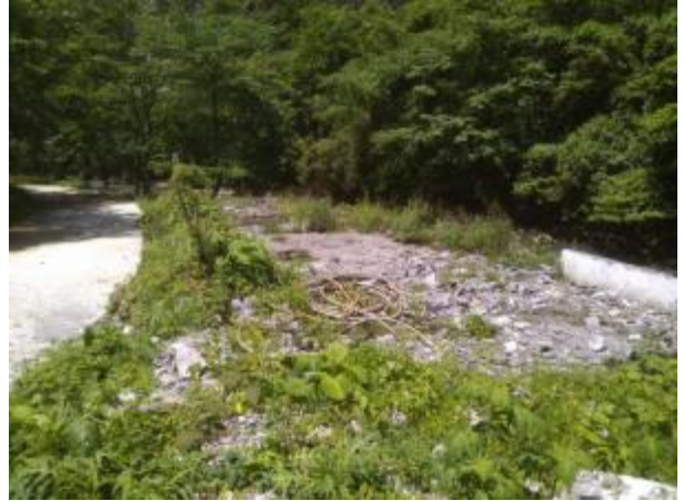
大坝砼浇筑队管理人员驻地
