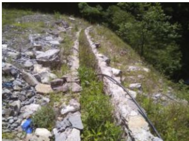
渣场排水沟（一）
