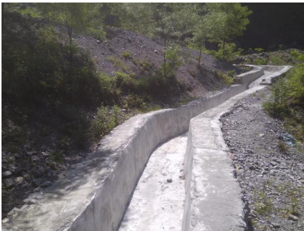
料场排水沟（一）
