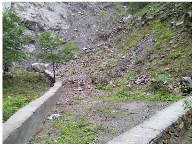
料场排水沟（二）
