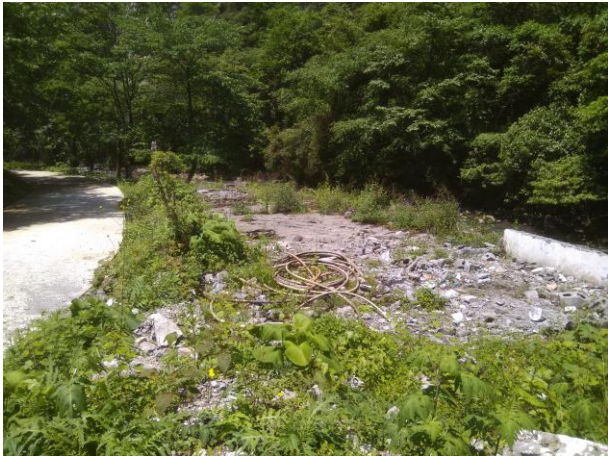
大坝砼浇筑队管理人员驻地
