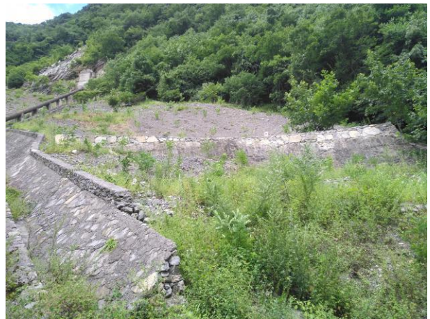
管道槽植物措施
