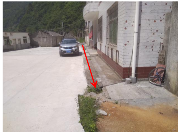
管理房排水沟
