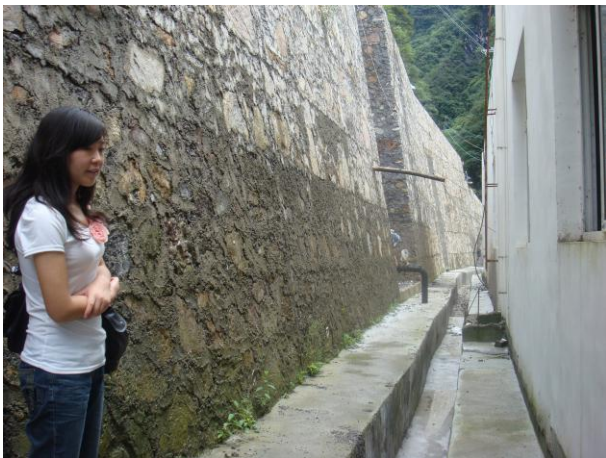
电站后排水沟
